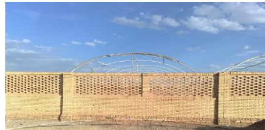
شکل (۲): بادشکن غیرزنده با الگوهای آجرچینی مشبک متداول و اصلاح دستی آن
