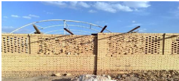
شکل (۲): بادشکن غیرزنده با الگوهای آجرچینی مشبک متداول و اصلاح دستی آن
