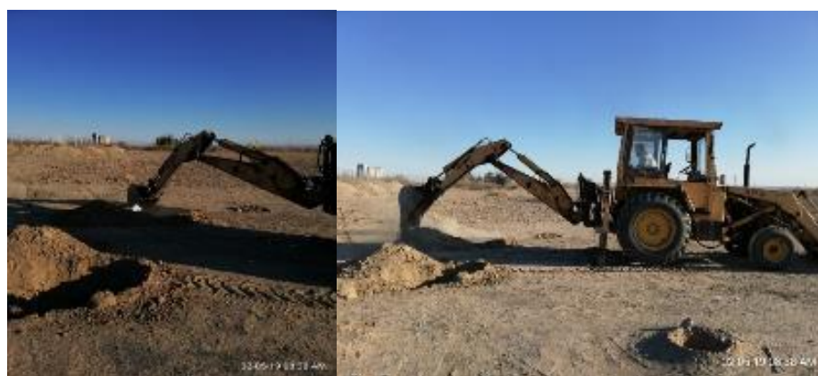
شکل (۵): حفر چال کود برای احداث باغ بذر (بهمن ۱۳۹۷)
