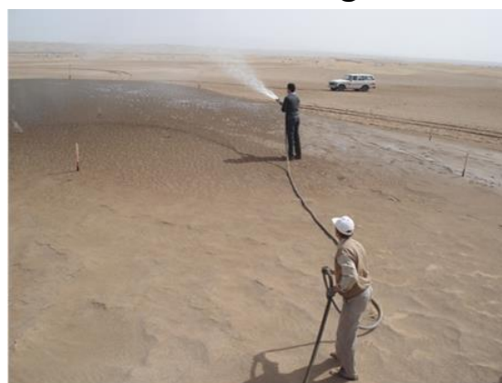
شکل (۴): مالچ‌پاشی روی تپه‌های ماسه‌ای
