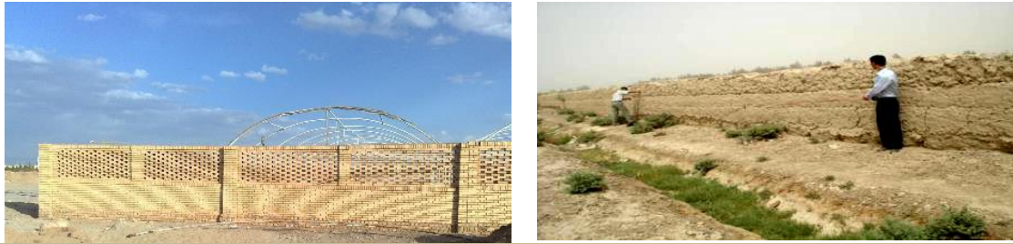
شکل (۱): بادشکن‌های غیرزنده با مصالح الف. گلی در اطراف مزرعه (امیری و همکاران، ۲۰۱۲): ب. آجری در اطراف گلخانه
