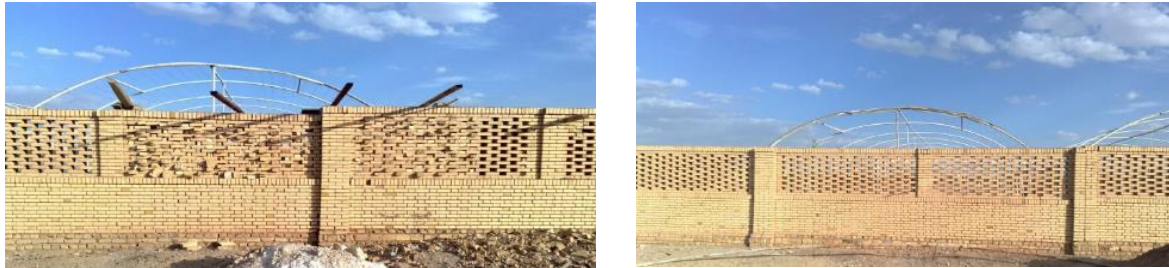
شکل (۲): بادشکن غیرزنده با آجرهای آجرچینی مشبک متداول و اصلاح دستی آن
